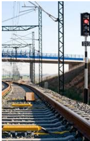
Figura 14. Eurobaliza. Fuente: tomada de (Mundo Ferroviario, 2022).
